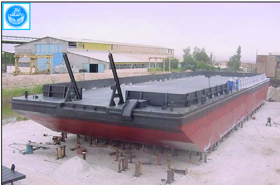
بارج در حال ساخت در کشتی سازی اروندان
